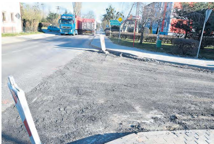
Prace, jak widać, trwają. Jest nowy chodnik i podbudowa pod drogę.
