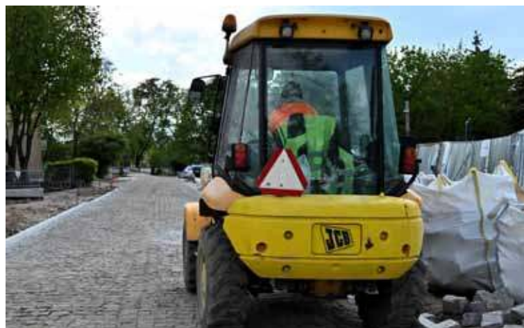
Od 1.07. (poniedziałek) zamknięty dla ruchu aut będzie odcinek ul. Bolesława Chrobrego od skrzyżowania z ul. Portową do skrzyżowania z ul. Szewską.
