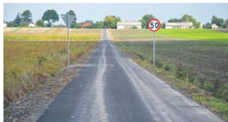
Przebudowa drogi dojazdowej w Żmudzi
