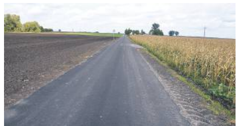
Przebudowa drogi w Klesztowie
