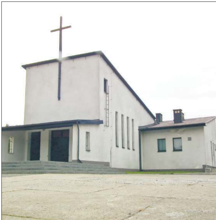
Kaplicę cmentarną przy ul. Wielopolskiej czeka remont.
