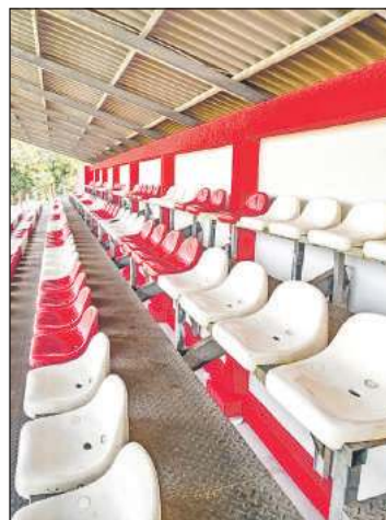
Prace na stadionie trwają.
