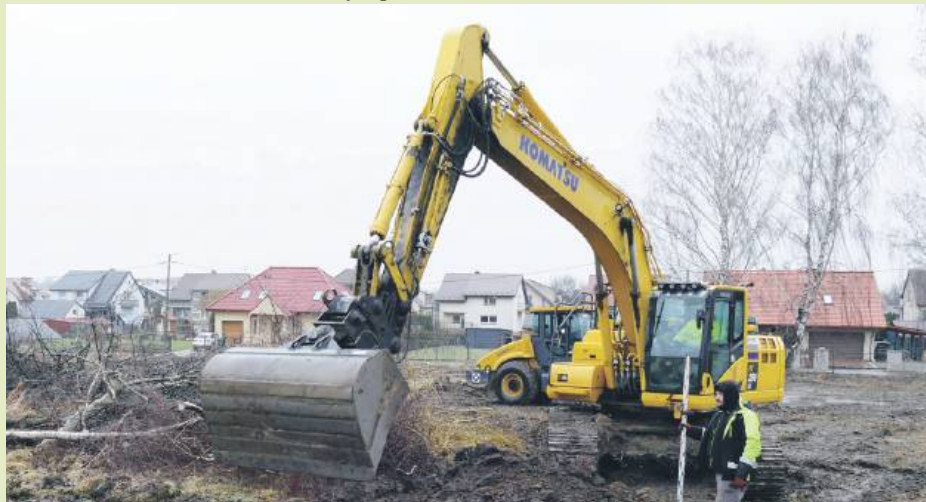
W Przewornie przed osiedlem na ul. Szkolnej w Przewornie ruszyła w ubiegłym tygodniu budowa marketu Dino
