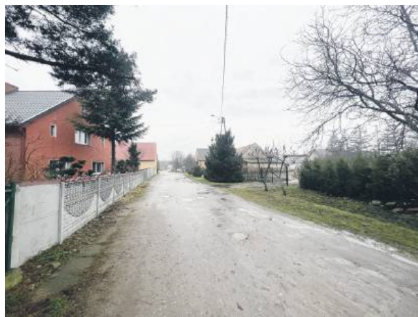
Droga gminna w Ludowie Śląskim, łącząca dwie drogi powiatowe, zostanie przebudowana
