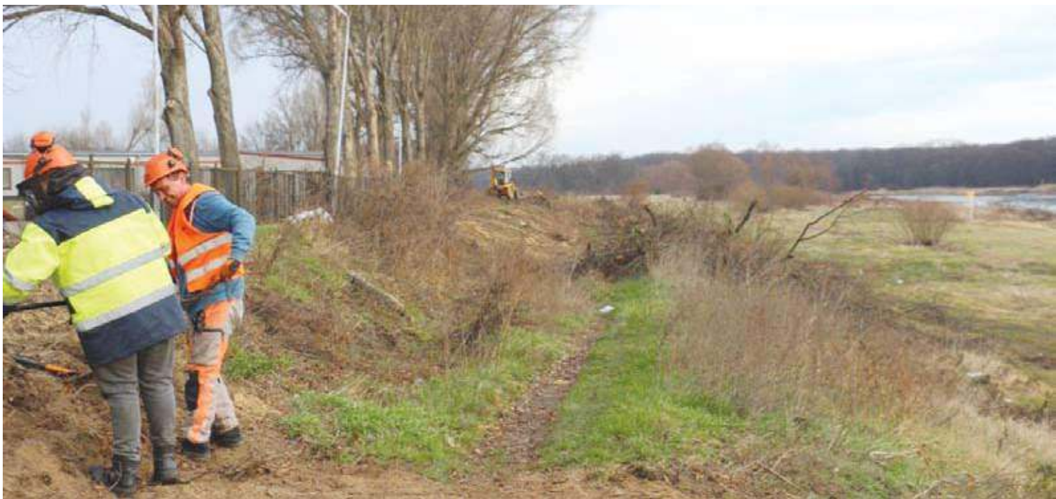
Prace rozpoczęły się w poprzednim tygodniu w okolicy ogrodów działkowych na wysokości ul. Ceglanej
