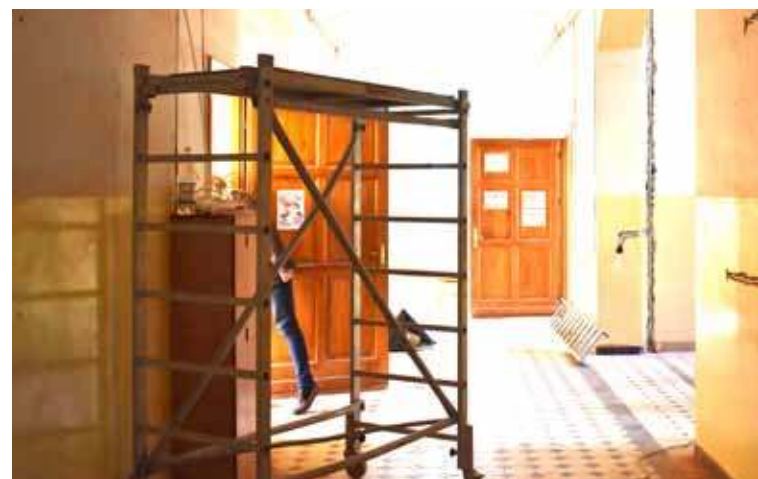
Nowe instalacje – elektryczna i centralnego ogrzewania – zwiększą bezpieczeństwo i zapewnią komfort korzystania z częściowo wyremontowanych pomieszczeń
