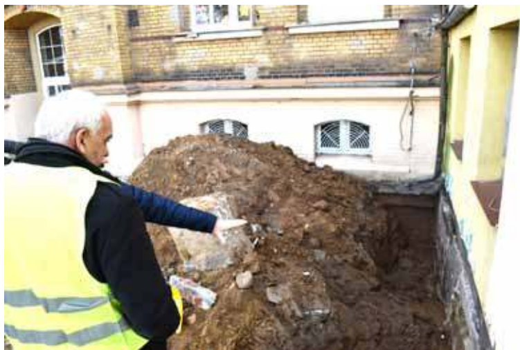
Na zewnątrz jeden z budynków zostanie docieplony. Będzie także nowoczesna centrala wentylacyjna, dzięki której uda się odzyskać nawet 80% ciepła
