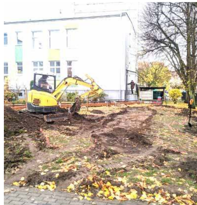
Obecnie trwają prace ziemne
