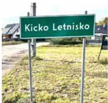
Po interwencji Dziennika widoczne na zdjęciu dziury zostały pokryte destruktem pochodzącym z remontu drogi w Starej Dąbrowie.
