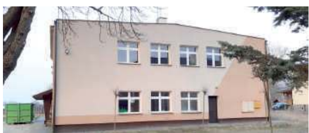
W budynku po byłej szkole w Skowieszynie schronienie może znaleźć 40 osób z Ukrainy
