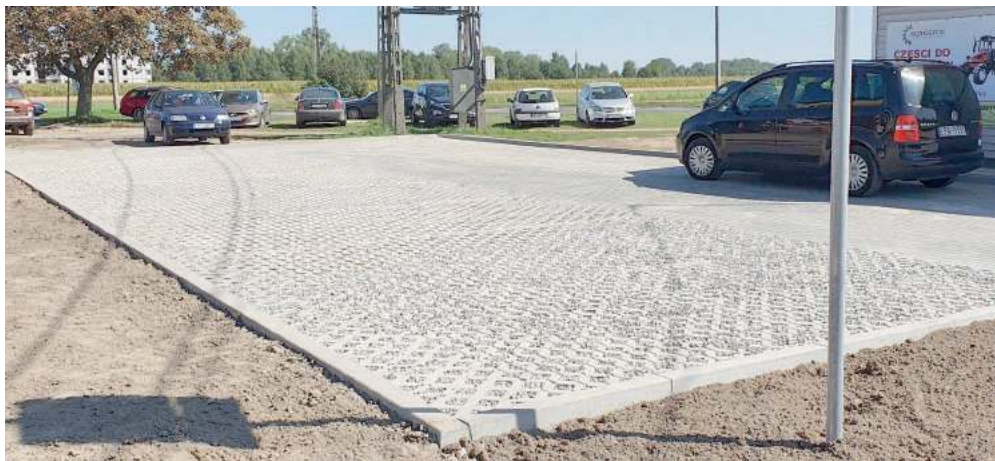
Nowe miejsca parkingowe zostały wykonane z płyt ażurowych
