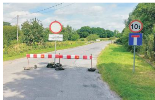
Ulica Brzegowa w Strzelinie jest zamknięta dla ruchu, a jest to związane z rozpoczętym remontem mostu
