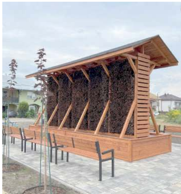
Tężnia solankowa została wybudowana w ramach Budżetu Obywatelskiego na 2024 rok
