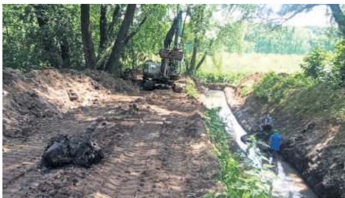
Demontażem kolektora zajęła się lokalna firma. Na zdjęciu z lewej widoczna kupa mułu i gałęzi, które powodowały niedrożność rur
