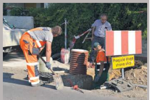
W Karszowie pracują już ekipy PZD. Foto: SP Strzelin
