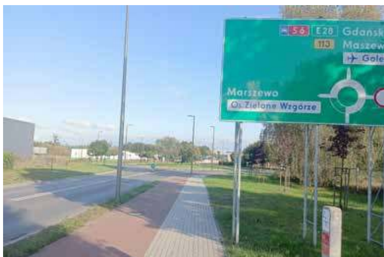
Na tym rondzie zakończy się pierwszy etap budowy ścieżki
