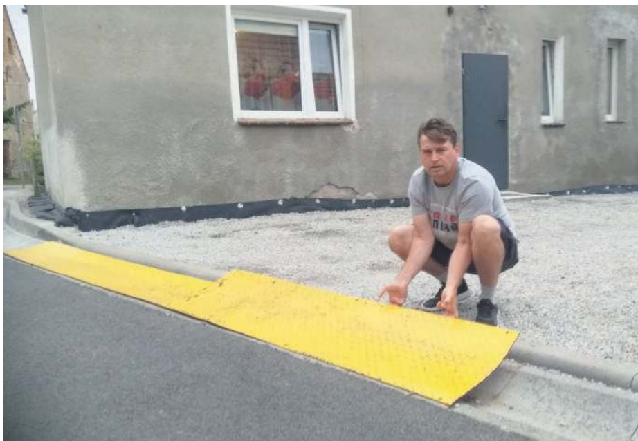
Adam Urbanowicz z Przeworna pokazuje uszkodzone płyty najazdowe do jego posesji
