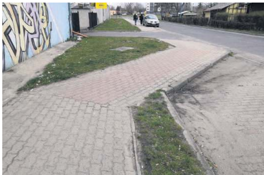
Po remoncie chodnik z prawej strony zostanie wyprostowany i będzie przebiegał wzdłuż budynków. W miejscu dotychczasowego chodnika powstaną miejsca parkingowe
