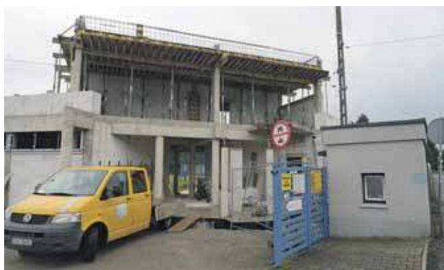
Budynek dawnej kasy zostanie wyburzony. Bilety będą sprzedawane przy wejściu do nowego pawilonu
