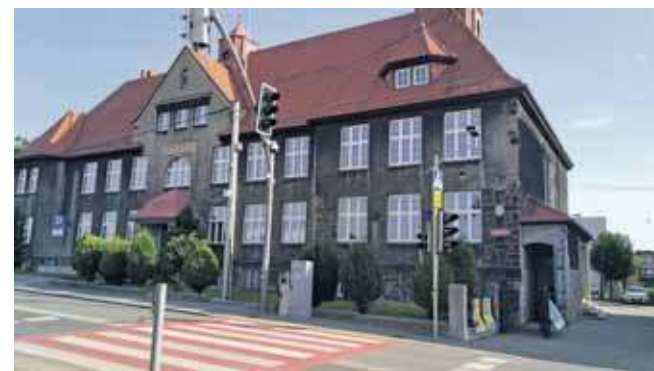
W budynku przy ul. Knosały nie będzie już szkoły podstawowej. W całości zajmie go przedszkole
