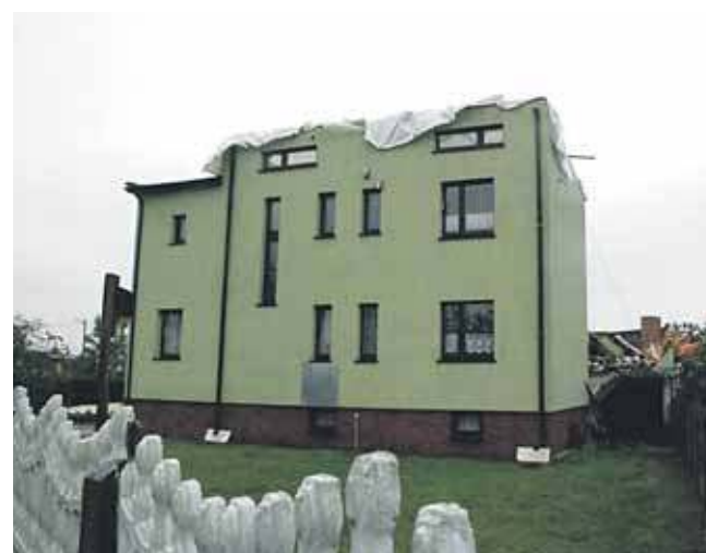
Zerwane dachy zabezpieczano tymczasowo folią i brezentem
