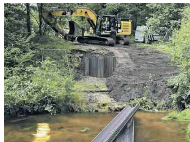
Budowa się rozpoczęła. Wykonawca ma czas do końca roku
