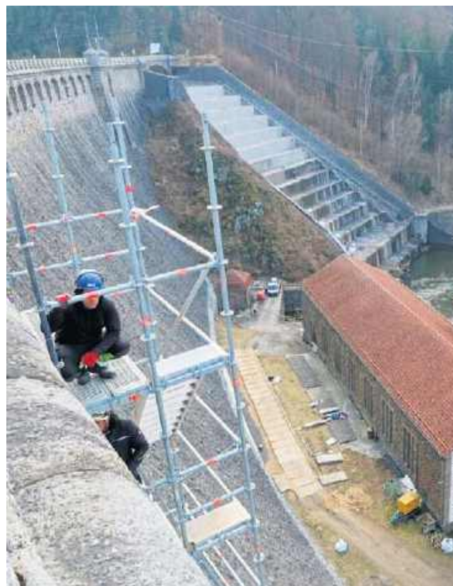
Rusztowanie będzie przesuwane wraz z postępem prac
