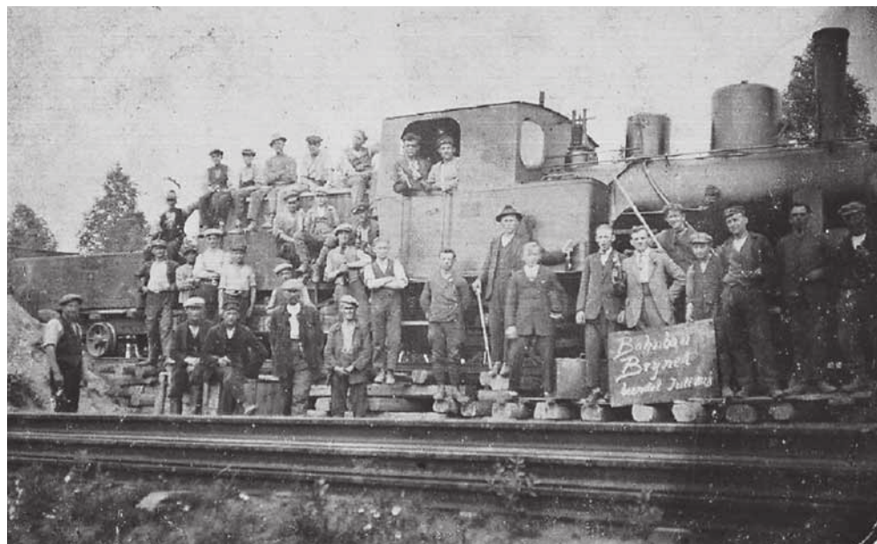
Zakończenie robót na stacji Brynek w lipcu 1928 r. Oficjalne oddanie linii kolejowej z Mikulczyc do Brynka nastąpiło około trzy miesiące później, 7 października
