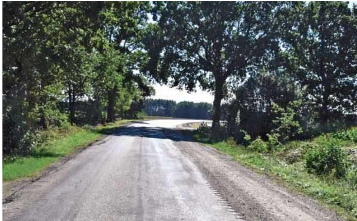
Dzięki inwestycji zostanie wzmocniona konstrukcja istniejącej jezdni (fot. powiat nowosolski)
