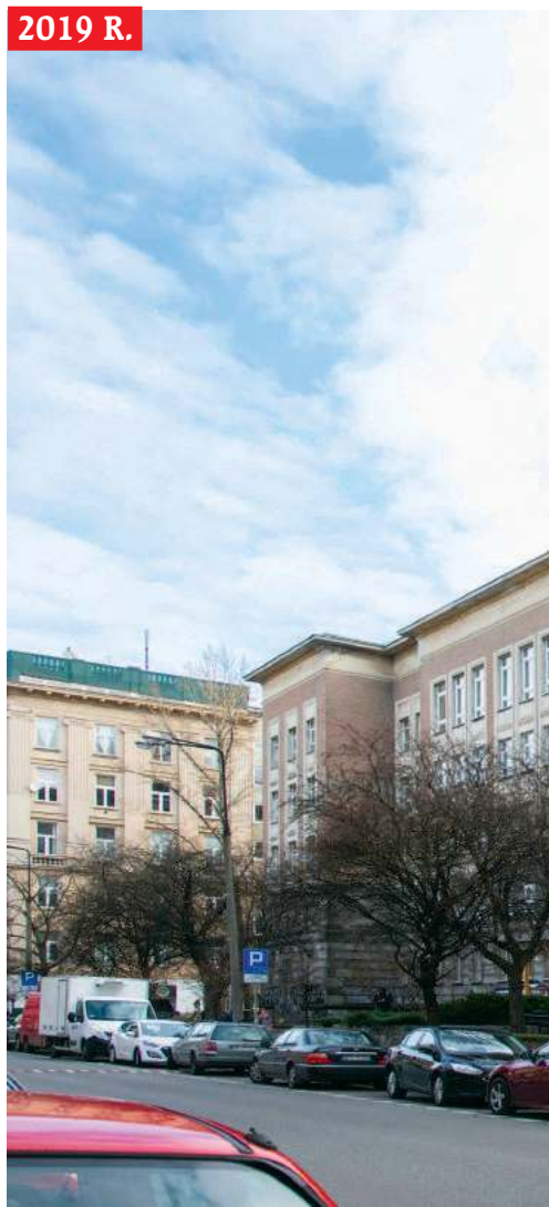
Urbanistyczna wyrwa w miejscu dawnej zabudowy | fot. Tomasz
