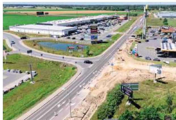
Tak powstaje wyczekiwane rondo przy stacji Shell
