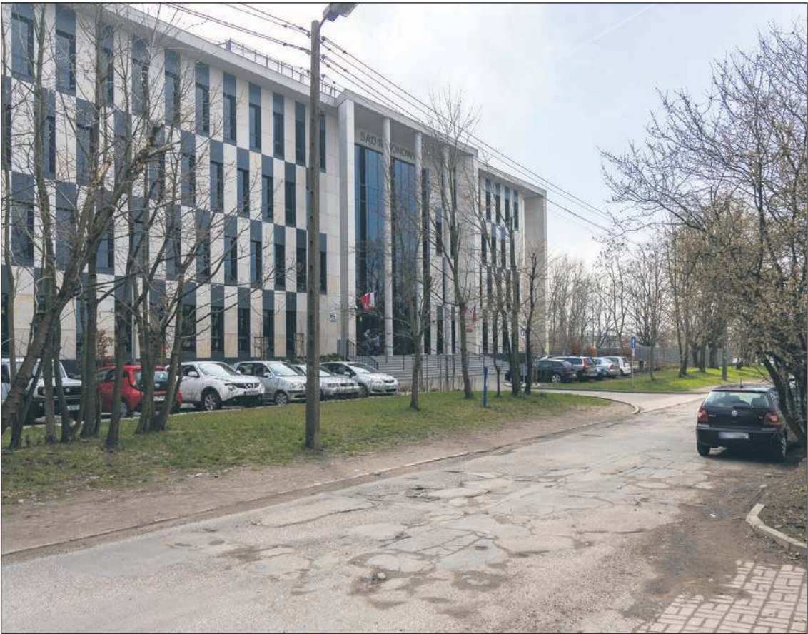
Na ul. 8 Pułku Artylerii Lekkiej wkrótce rozpocznie się modernizacja drogi
