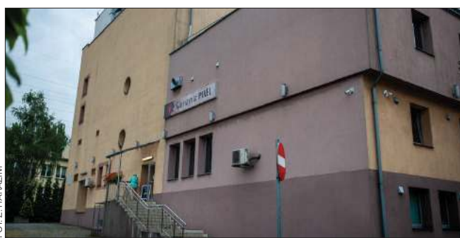
Ściana RCK „Feniks” przeznaczona na mural w konkursie „Blask Szarloty – potencjał wydobyty”
