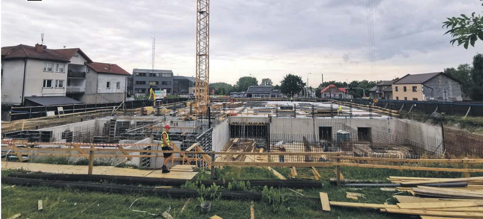
Budowa u zbiegu ulic Krakowskiej i Ochronkowej
