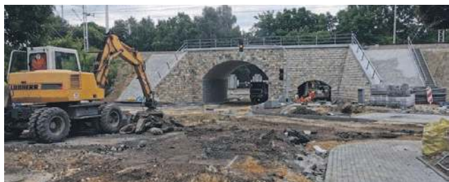
Prace na ul. Siennej w rejonie wiaduktu kolejowego
