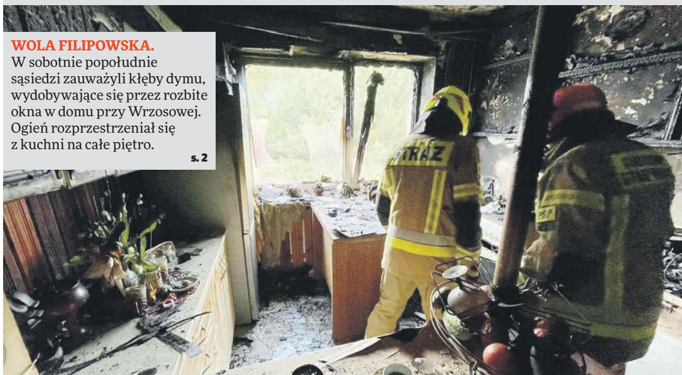
Spalona kuchnia w domu przy Wrzosowej w Woli Filipowskiej
