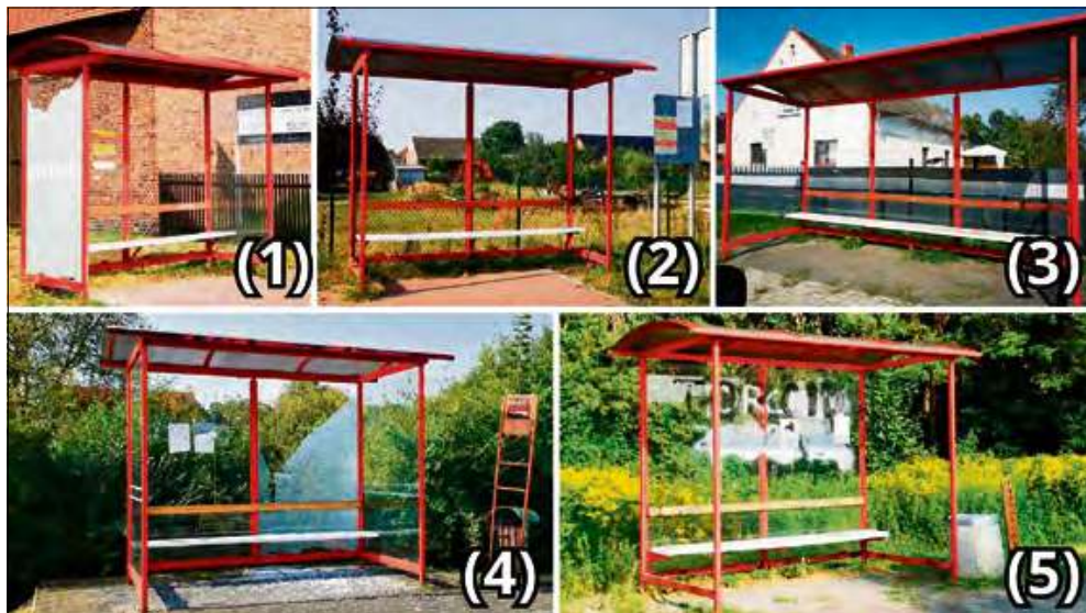
Uszkodzone przystanki w Januszkowicach przy DW 423 na ul. Wolności – niedaleko skrzyżowania z ul. Zamkową i Działkowca (1) oraz na ul. Wolności (2). Zniszczone przystanki w Krępnej przy ul. Stawowej (3), Rozwadzy na ul. Góry Świętej Anny (4) oraz w Zdzeszowicach na ul. Żyrowskiej (5).
