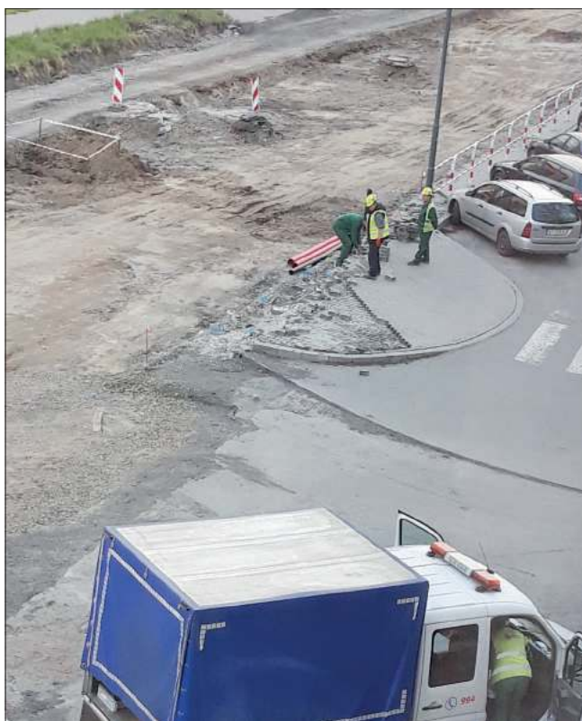
Mieszkaniec Ostroga zwrócił uwagę na pracowników Wodociągów Raciborskich, którzy ładowali na samochód kostkę brukową z przebudowywanej ulicy Bosackiej w Raciborzu. Okazało się, że zrobili to w porozumieniu z firmą wykonującą przebudowę drogi (formalnie to właśnie ta firma jest właścicielem kostki), ale bez wiedzy przełożonych.
