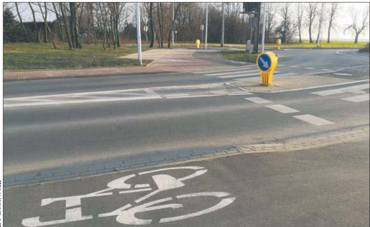
W Płocku ustawiono 32 stację rowerową u zbiegu ulic Traktowej i Szpitalnej
