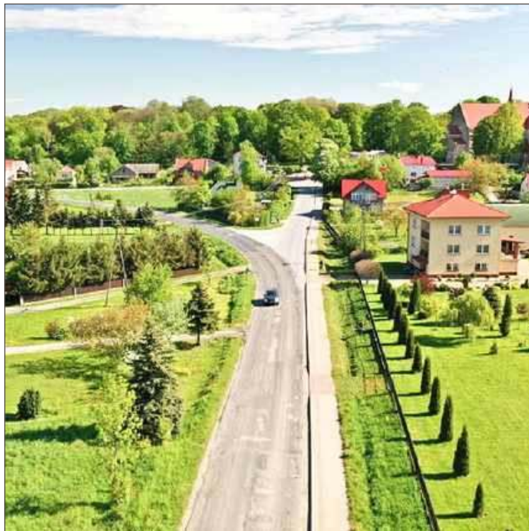
Droga wreszcie doczekała się przebudowy.
