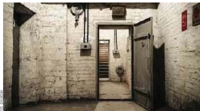
W Elblągu zgodnie z prawem budowlanym prowadzone są kontrole okresowe budowli ochronnych i jest to coroczny przegląd budowlany
