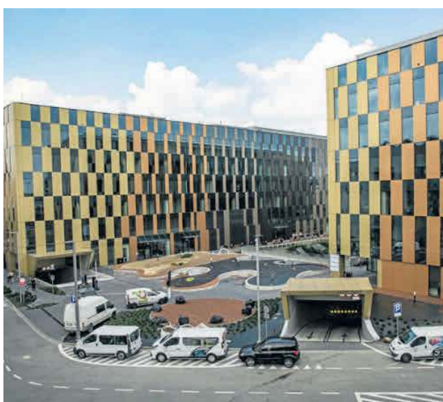
Przy ulicy Pawiej powstaje kompleks HighFive, który zostanie ukończony w 2022 r. i zaoferuje 75 tys. mkw. powierzchni
