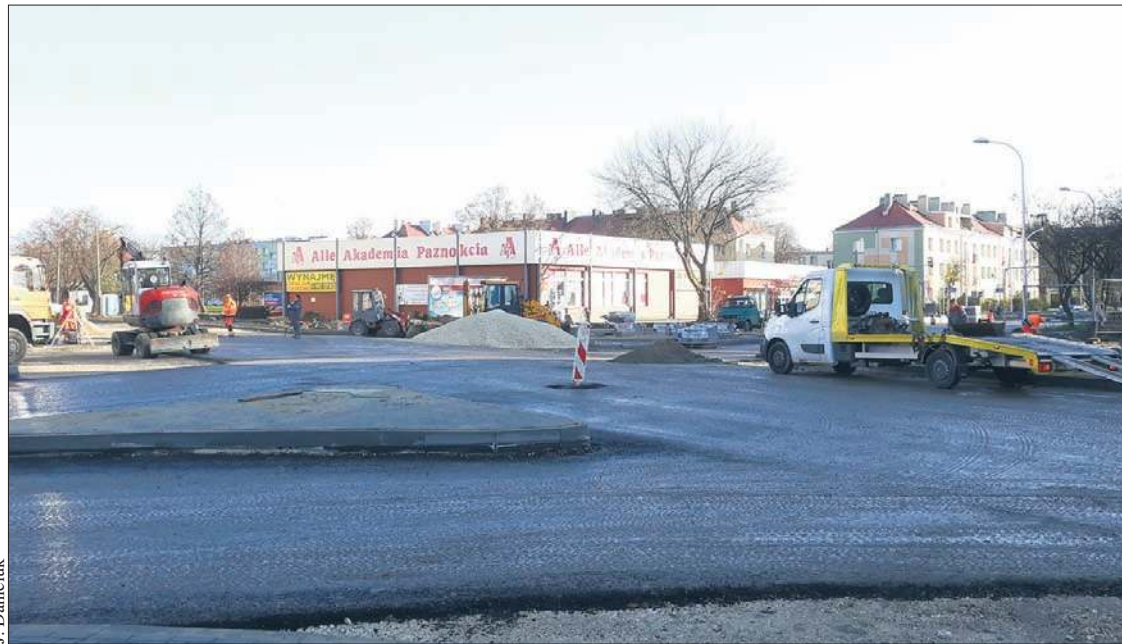
Widać już jak będzie wyglądać po przebudowie skrzyżowanie ul. Tysiąclecia i Bielskiej
