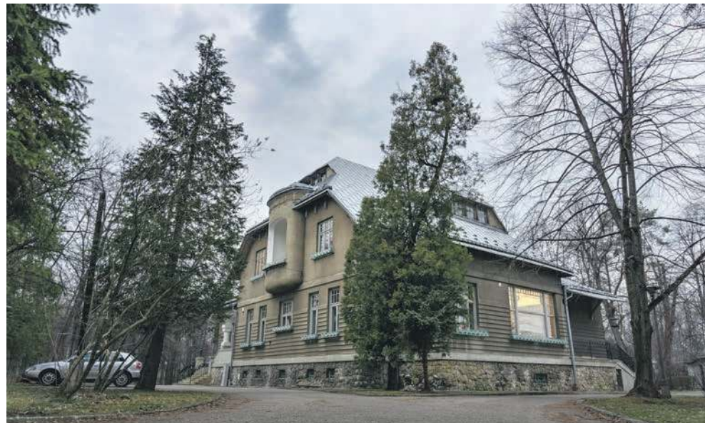
Widok od strony bramy wjazdowej
