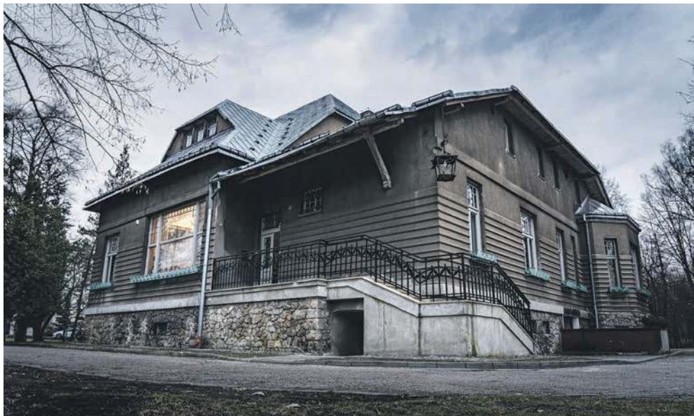
Widok od strony wejścia
