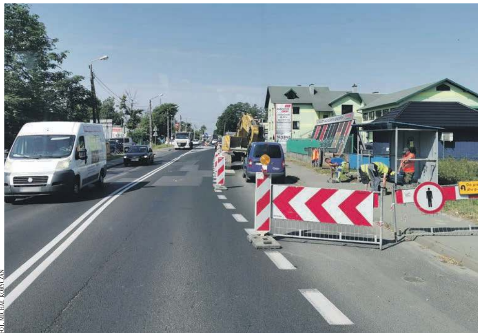
Rozpoczęła się naprawa przepustu biegnącego pod ul. Długą w Trzebinii
