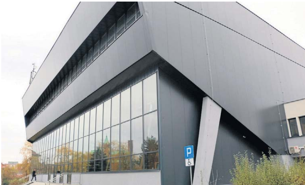
Hala sportowa w Czeladzi po remoncie elewacji będzie miała także odnowione wnętrza
