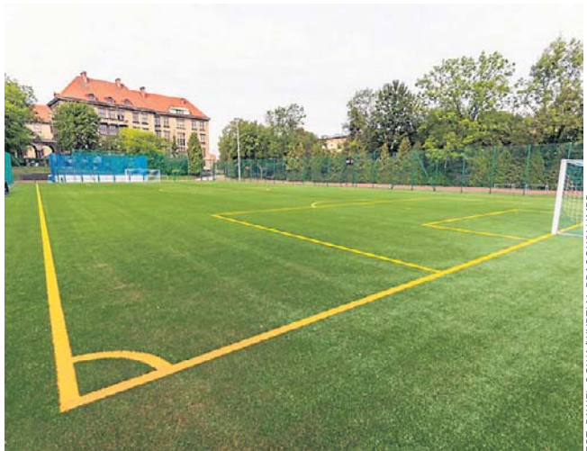
Gruntowna przebudowa Orlika objęła m.in. wymianę nawierzchni boiska piłkarskiego
