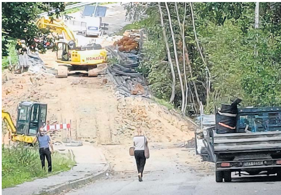
Prace trwają, ale ruch w rejonie budowy jest znacznie utrudniony
