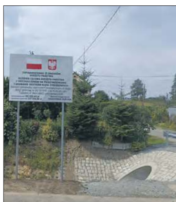
Przepust w Rudziczce
