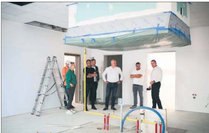
Budowa MP nr 17 jest na finiszu. Rok szkolny przedszkolaki rozpoczną w nowej siedzibie
