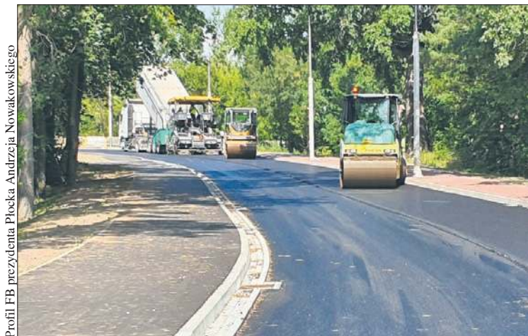
Dobiega końca przebudowa ulicy Raczkowizna
