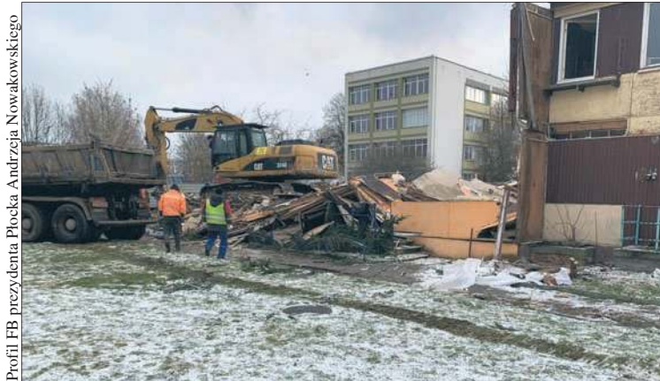
Prace przy budowie nowego bloku przy ul. Miodowej 51 rozpoczęły się od wyburzenia starego budynku
