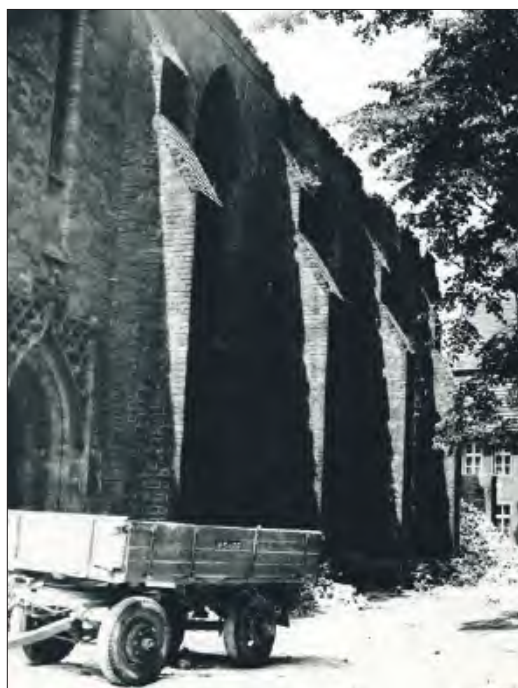
Cegły z rozbiórki były cennym materiałem budowlanym
