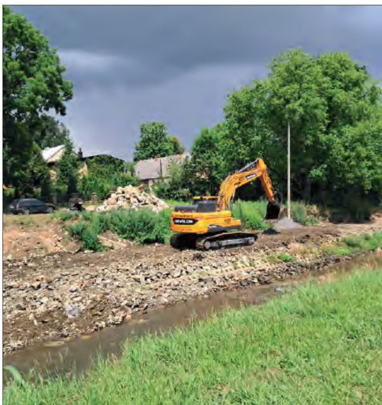
Historyczny moment rozpoczęcia prac popowodziowych
