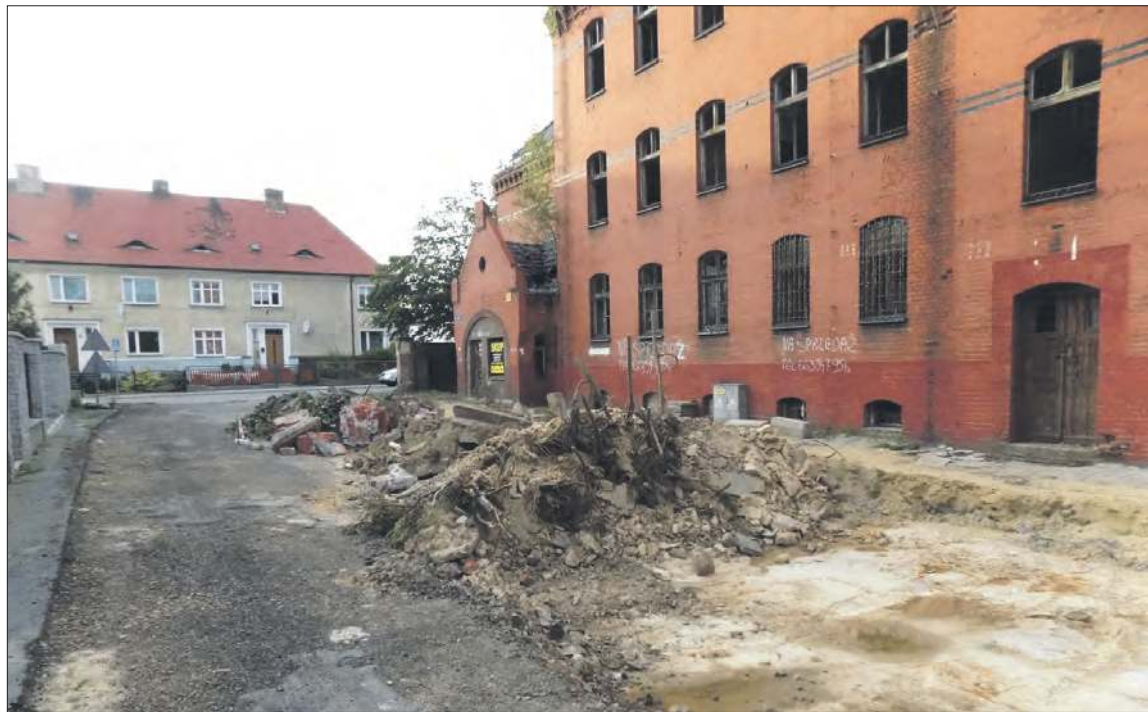
Jezdnia i chodnik są już wyremontowane, budynek nie
