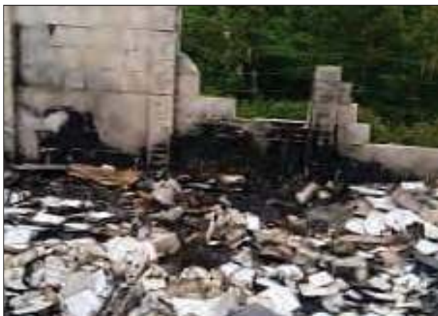
Pogorzelisko nadal jest nieuporządkowane, a budynki są w takim stanie, jak na drugi dzień po pożarze (fot. Elżbieta Lewtak)
