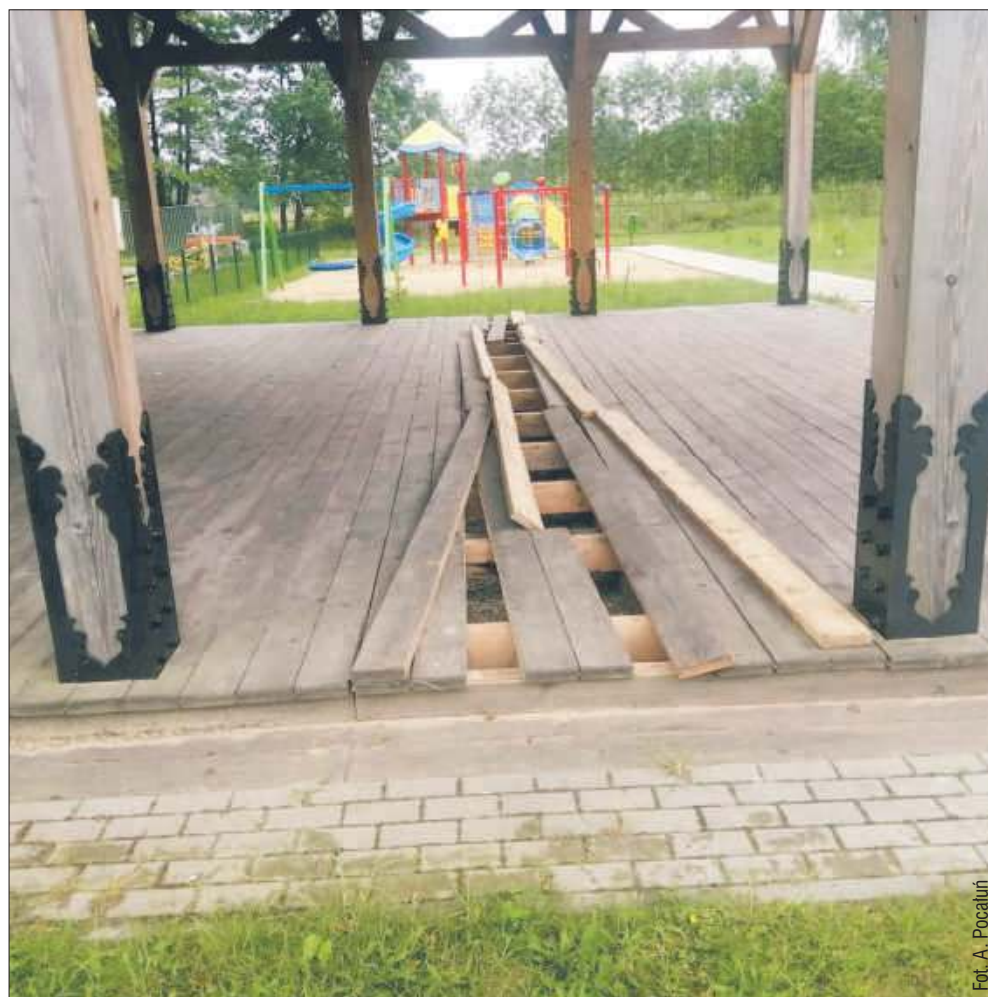
Gmina Kolbuszowa na ten cel otrzymała 585 tys. złotych unijnego dofinansowania, a ze swojej kieszeni wyłożyła około 187 tys. zł. Są to sceny konstrukcji drewnianej o wymiarach 10 x 15 metrów każda. Wszystkie posiadają dwuspadowy dach pokryty gontem.
