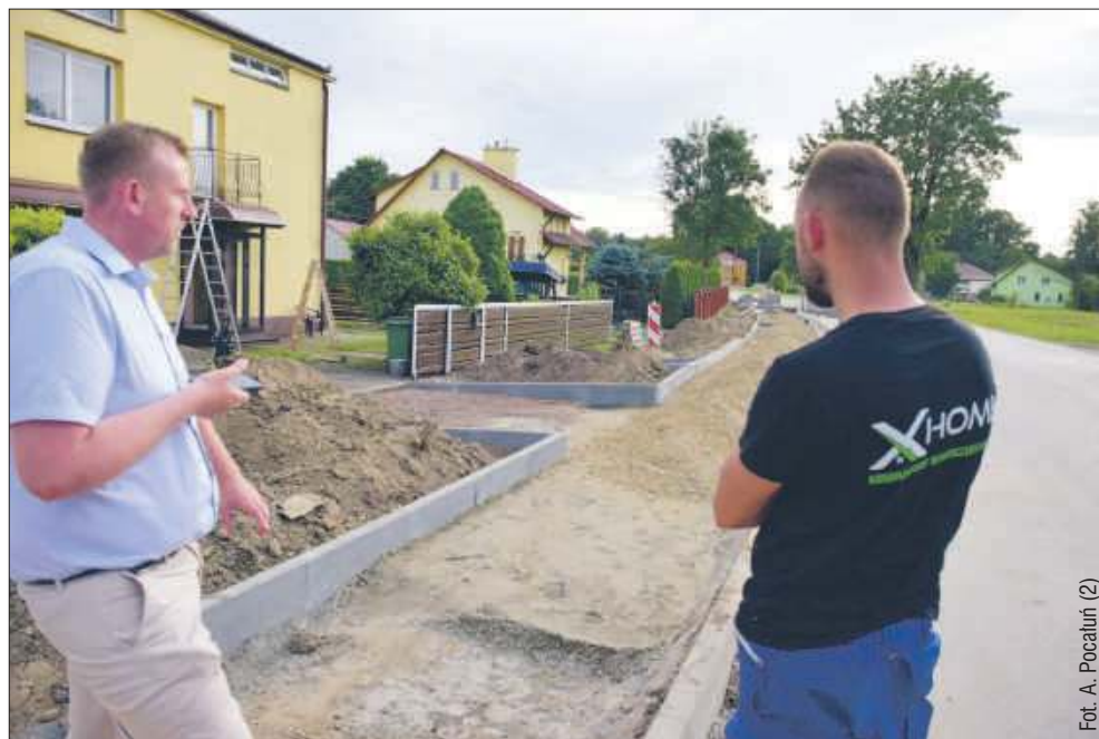
Prace przy chodniku w Widelce postępują, a mieszkańcy obawiają się pierwszych ulewnych deszczy.
