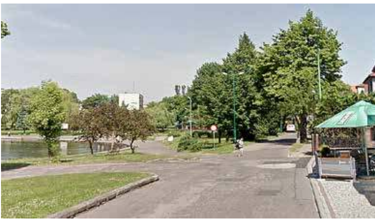
W planie jest również przebudowa odcinka w pobliżu restauracji Przystań
