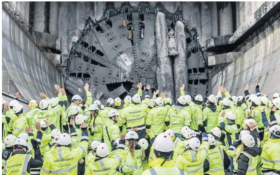
Po skończeniu drażnienia pierwszej nitki tunelu maszyna TBM przejdzie serwis, zostanie obrócona i wiosną przyszłego roku ma rozpocząć drażnienie drugiej nitki
