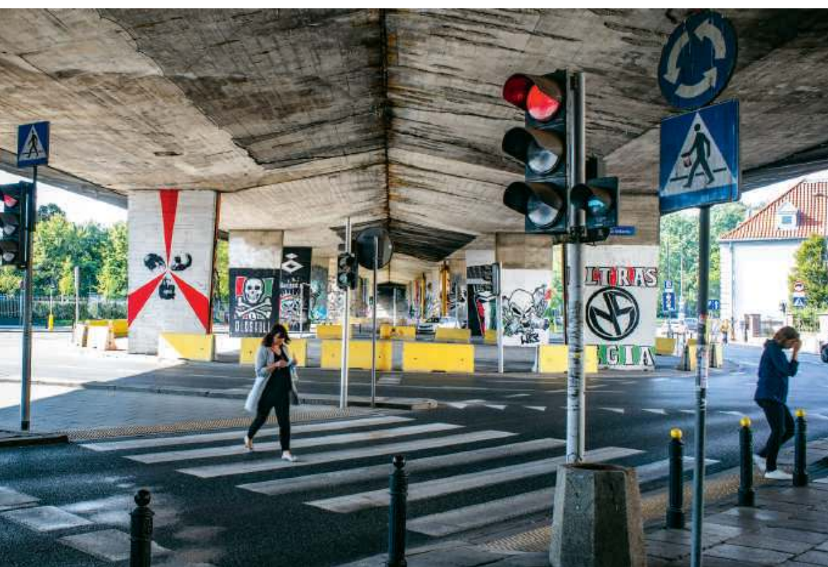
Przebudowa wiaduktów potrwa do marca 2024 r. | fot. Zbyszek Kaczmarek/Gazeta Polska
