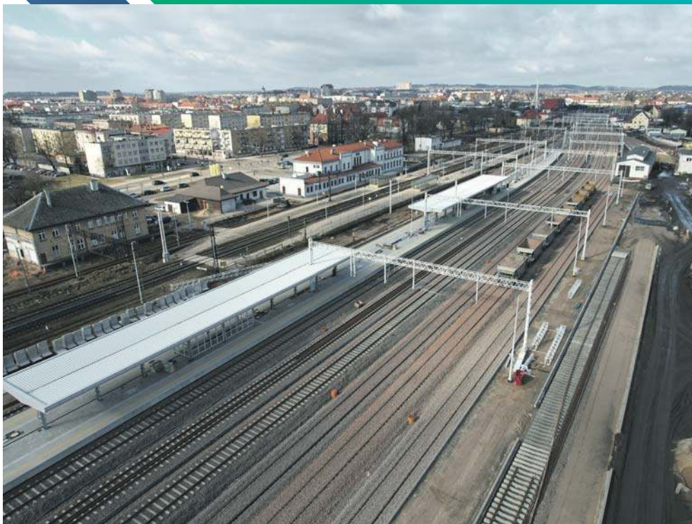
Na stacji Ełk dobiega końca budowa peronu
