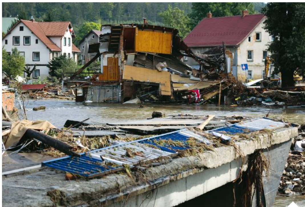
W wielu miejscach nie ma podstawowej informacji o liczbie zniszczonych mieszkań i budynków | fot. Wojciech Koziol/Forum
