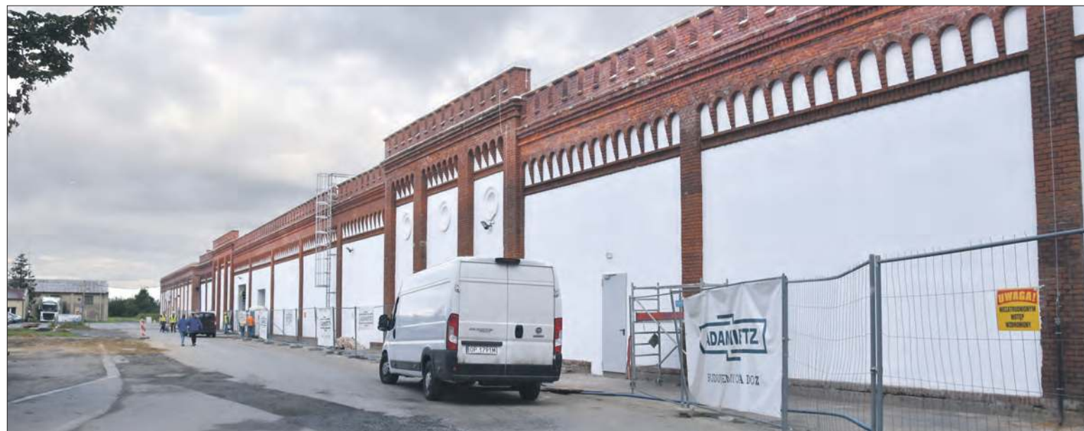
Zmodernizowana część hal ma już odnowioną elewację
