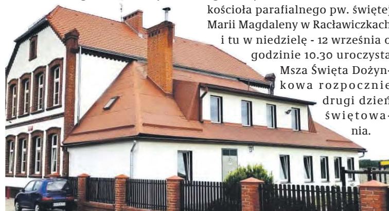
Pięknie odnowiony budynek przedszkola i świetlicy
