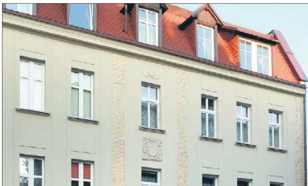
Katowice, ul. 1 Maja 96, ul. Żółkiewskiego1
