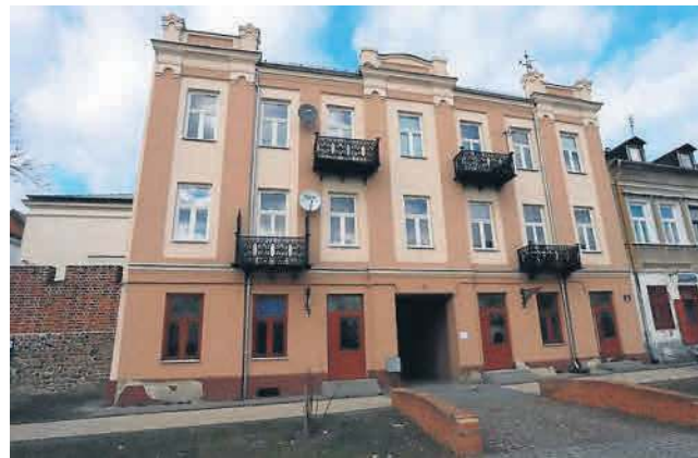
Przy ulicy Wałowej 22 wykonawca rozpoczął remont piwnic, będzie też robiona instalacja centralnego ogrzewania.
