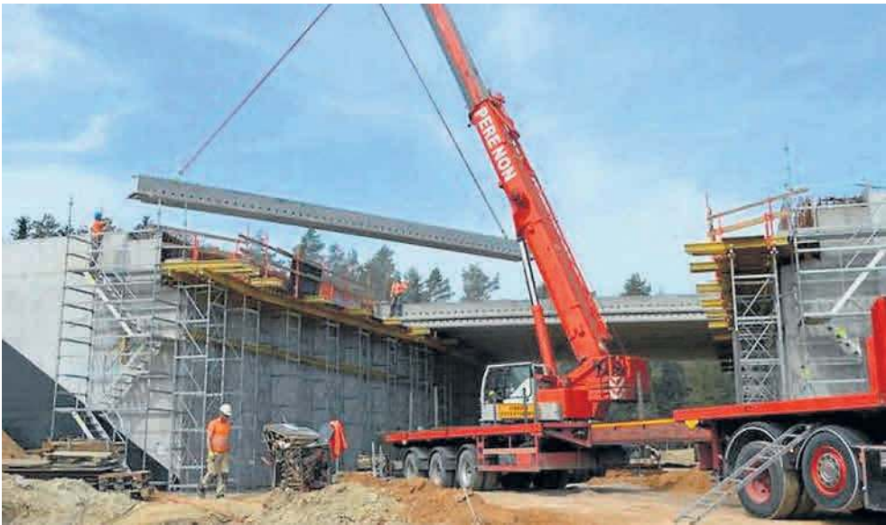
Trwa budowa trasy przy granicy województwa świętokrzyskiego i mazowieckiego.
