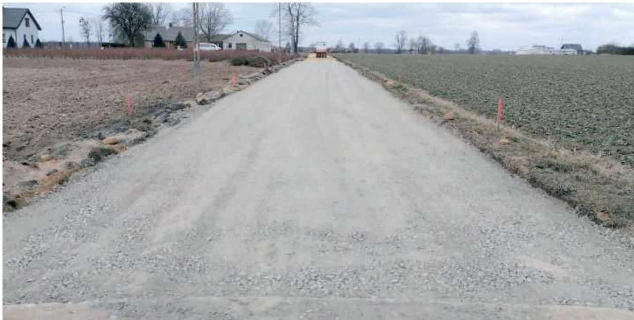
W gminie Jabłoń trwa m.in. budowa drogi nr 103788L
