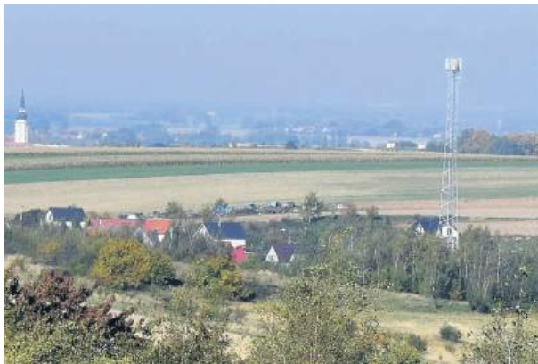
Stacja bazowa telefonii komórkowej na polu pomiędzy Kuropatnikiem a Gościęciami Górnymi. Foto: archiwum Słowa
